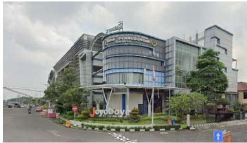
Sisi Timur Terminal Joyoboyo Sumber: Google Earth, 2023
